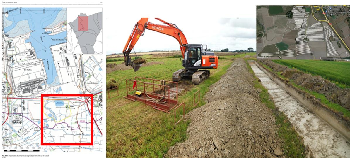
**Figure 5.2.3** A gauche, l'emprise du domaine prospecté à Loon-Plage. A droite, creusement des tranchées préalable au diagnostic archéologique (l'encart montre l'ensemble des tranchées réalisées pendant une saison de fouilles, le diagnostic s'étend sur 4 ans). On voit dans la tranchée des niveaux argileux dans le sable, dont la géométrie peut être reconstituée en profondeur avec le géoradar.
